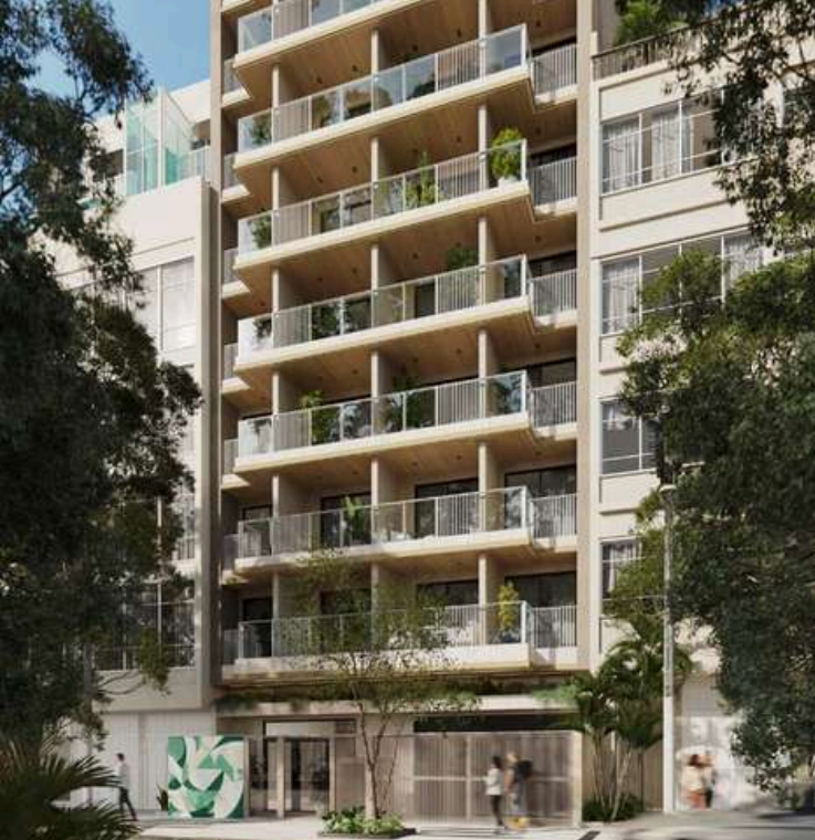
BARÃO DA TORRE NOVA CONSTRUÇÃO
